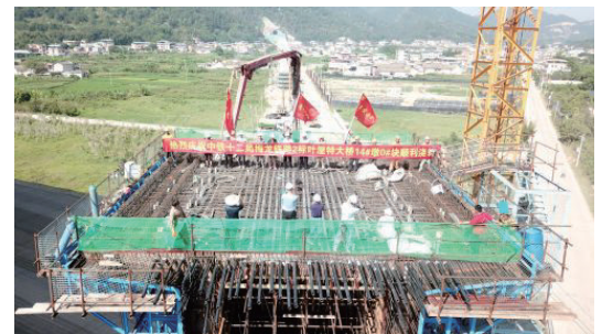
梅龍高鐵葉屋特大橋首個連續梁澆築施工現場。(鄭昌宏 攝)
